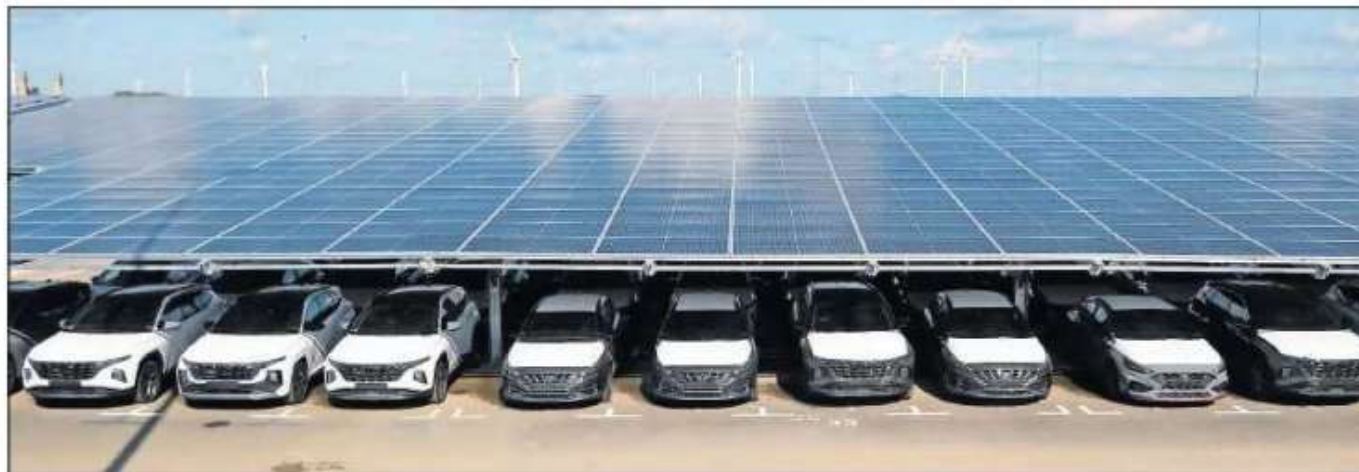
Autos unter Solarpanelen: Wie hier bei einem Auto-Logistikunternehmen kann mit Photovoltaik auf Parkplätzen Strom erzeugt werden.
